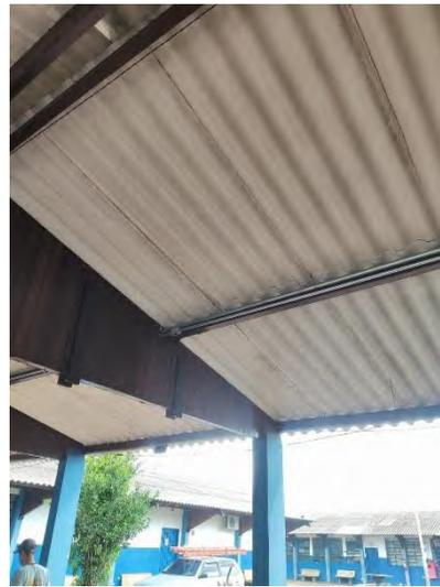
Figura: Eletrodutos instalados
