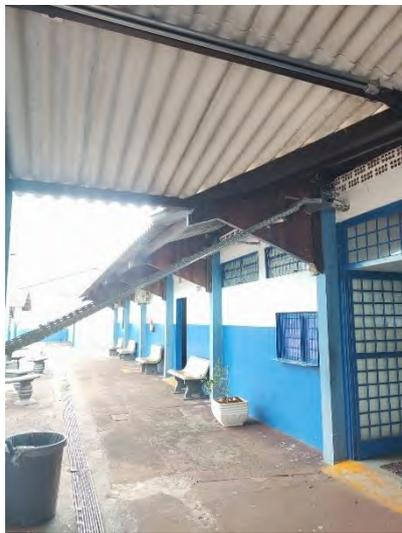
Figura: Retirada das eletrocalhas
