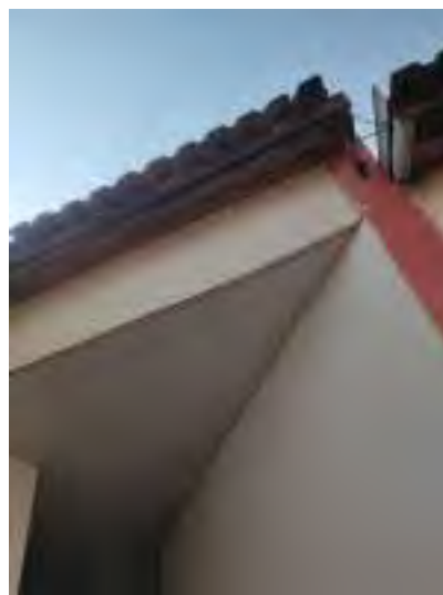
Foto: Forro trocado
