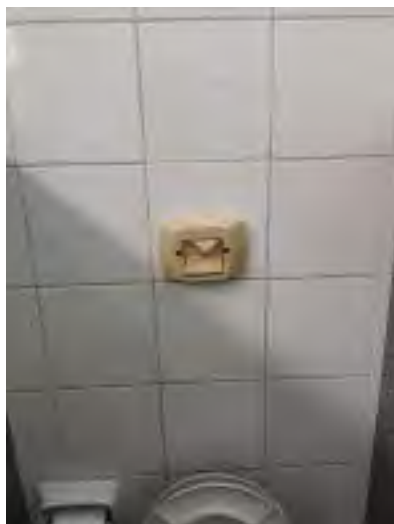
Foto: Válvula descarga quebrada
