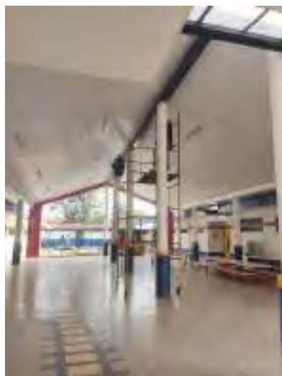
Foto: Reparos pátio
