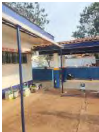
Foto: Pintura área externa
