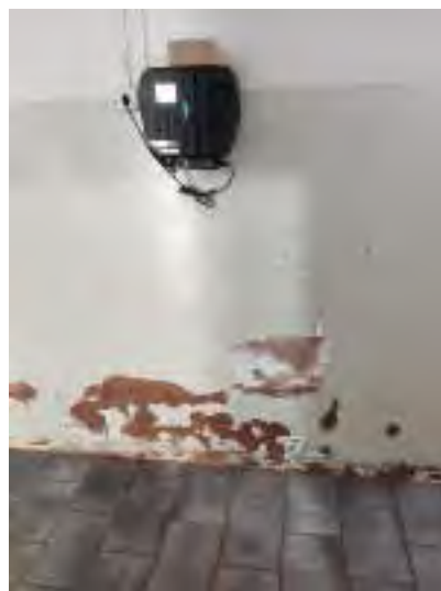
Foto: Parede área interna.
