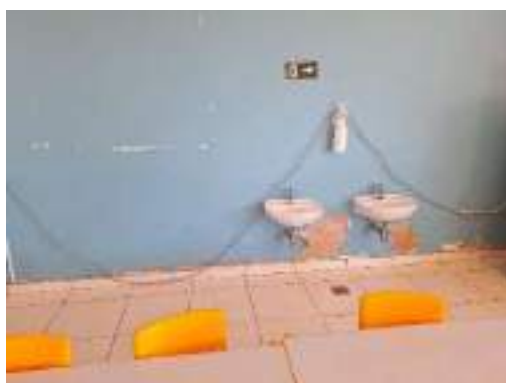
Figura: Parede refeitório.
