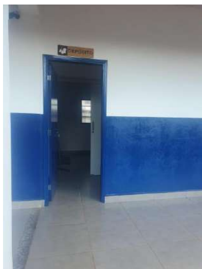
Figura: Entrada depósito/lavanderia.
