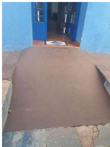
Figura: Rampa acesso entrada.
