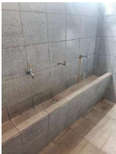
Figura: Pia banheiro externo.
