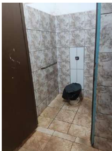
Figura: Banheiro interno.
