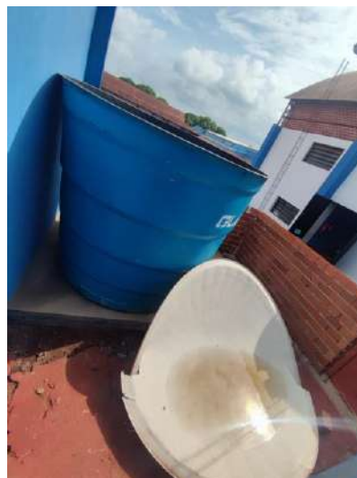
Figura: Caixa d'água.
