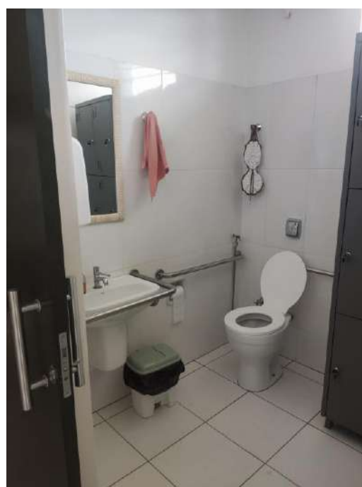
Figura: Banheiro interno.
