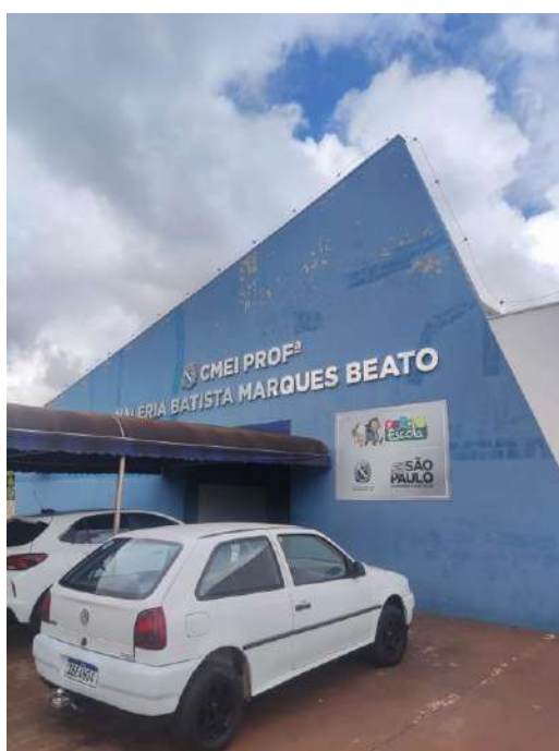
Figura: Faixada da Escola.
